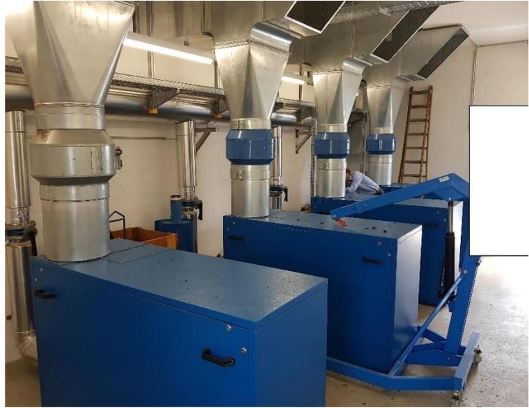
**Abbildung 2** Aufstellung der Baratti Drehkolbengebläse inkl. Schallschutzhauben auf der ARA Kölliken
