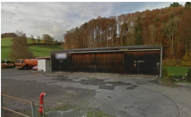
Ehem. Werkhof Hinterwil vor Rückbau
