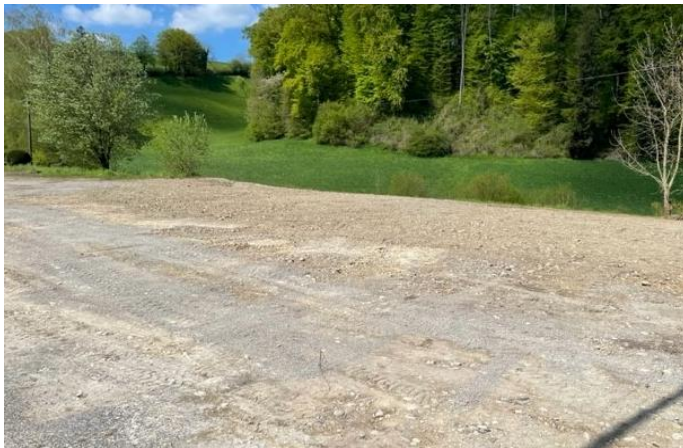
Situation nach Rückbau vor ökologischer Aufwertung
