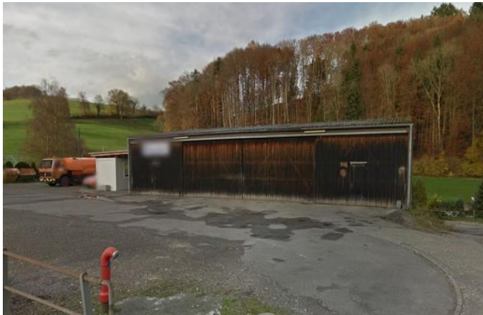
Ehemaliger Werkhof Hinterwil vor Rückbau
